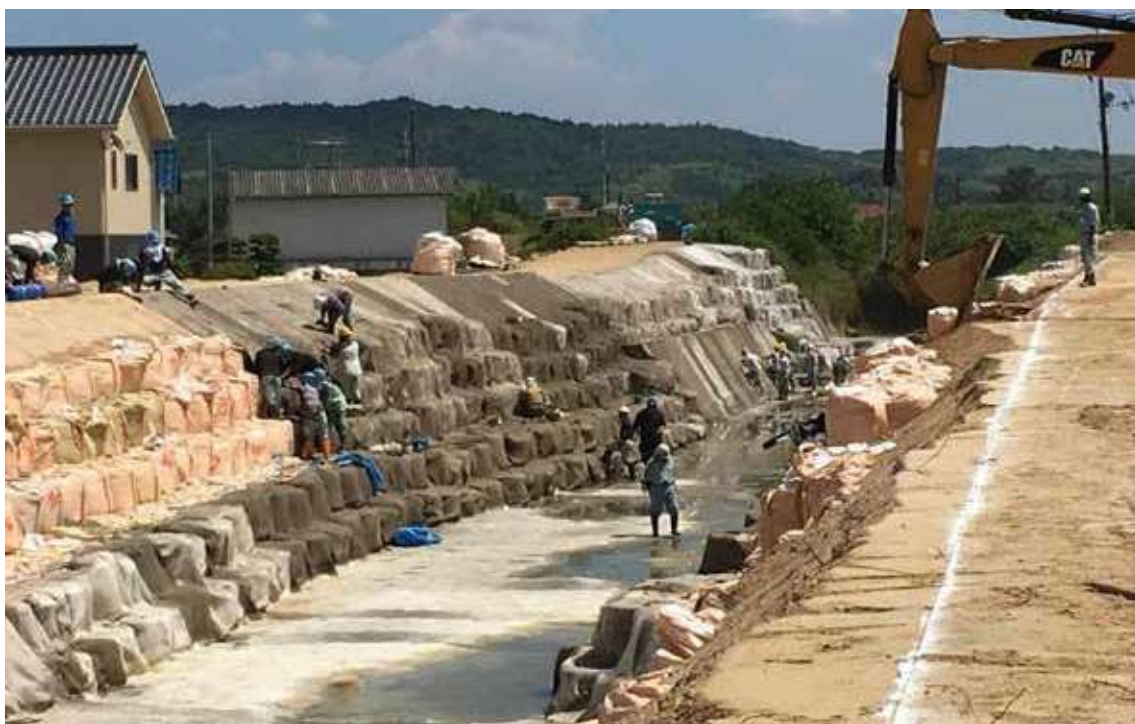
西日本豪雨 飯 未政川堤防決壊応急復旧（岡山県真備町）
