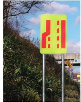
車線減少 施工例
